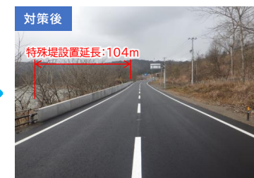
道路沿いに特殊堤を設置
