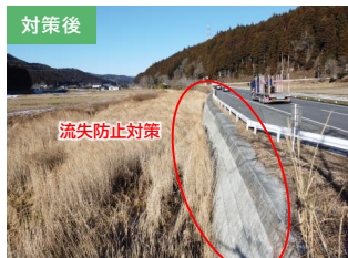
道路流出対策を実施
