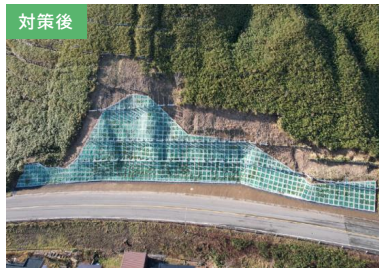
同区間において法面対策を実施
