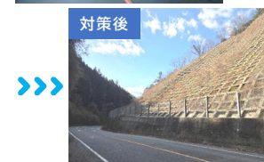
法面対策(吹付砕工)
