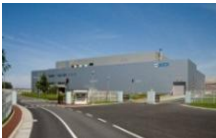
JESCO(高濃度PCB廃棄物処理施設)
