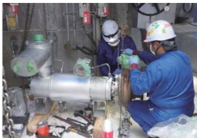
処理施設における補修作業
