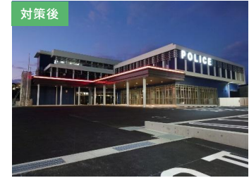
対策後 現地建替により、災害発生時における警察活動の中核拠点としての機能を確保
