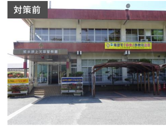
対策前 建築後50年以上経過した老朽化した警察署であり、耐震性も不十分な状況
