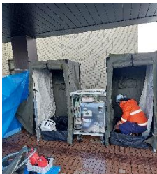
シャワールーム設置状況
