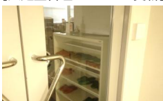
サーバ室のセキュリティ確保
