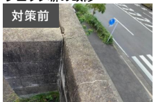
ブロック塀をフェンスに改修することにより、ブロック塀の倒壊による歩道の歩行者への被害を防止
