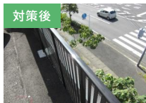
ブロック塀をフェンスに改修することにより、ブロック塀の倒壊による歩道の歩行者への被害を防止
