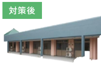
柱や梁の増築、基礎及び外観の補強等により、施設の耐久性が向上
