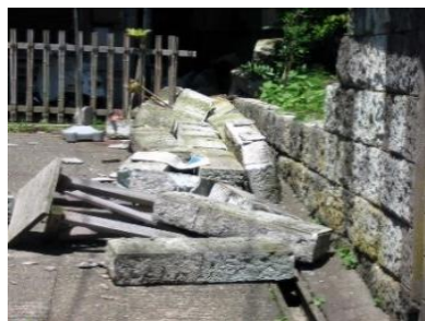
ブロック塀の改修等により、地震によるブロック塀の倒壊を防止
