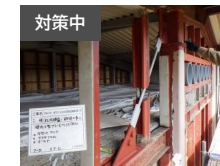
壁内Xブレース取付
