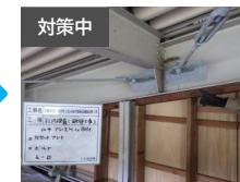
水平ブレース取付
