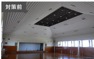
特定天井(天井仕上げ材及び下地材)の撤去、落下防止の天井設置機器(照明器具・火災報知器など)の更新工事、天井仕上げ撤去に伴う内装改修工事を実施
