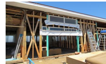
整備中の様子
