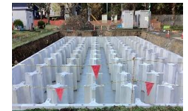
公園の地下に雨水貯留浸透施設を設置
