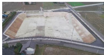
洪水時に一時的に水を貯留し、水路への流出を調整
