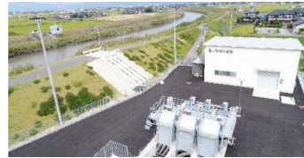
排水機場の新設により排水能力を強化
