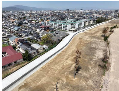
高潮等から市街地を防護する海岸堤防の整備
