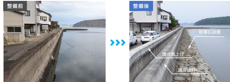
護岸の整備により、対象地震発生後も背後地の浸水被害を未然に防止
