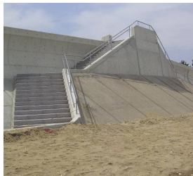
階段・スロープ等の整備
