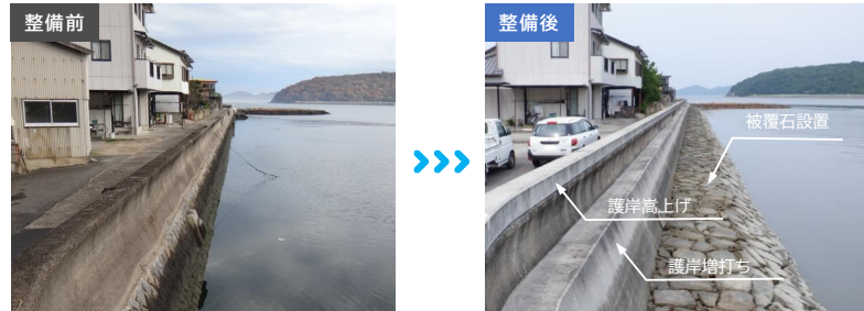
護岸の整備により、対象地震発生後も背後地の浸水被害を未然に防止
