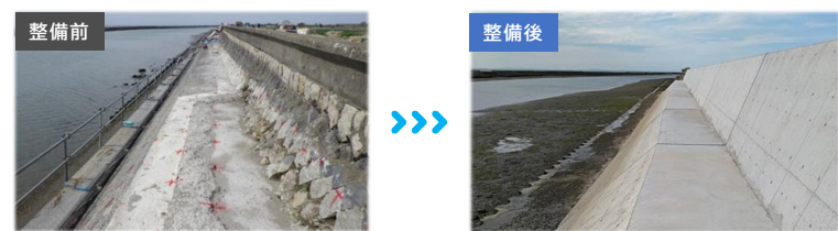
高波等から背後地を防護するための堤防整備
