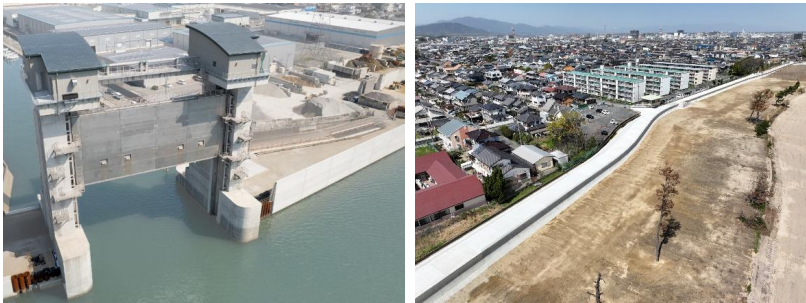
津波から市街地を防護する水門整備
