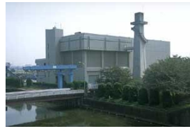
排水機場の整備
