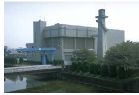
排水機場の整備
