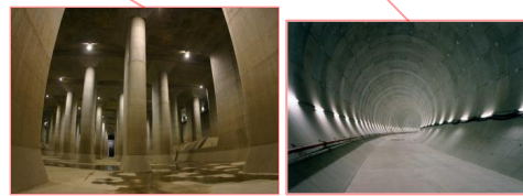
首都圏外郭放水路(調圧水槽) シールドトンネル
