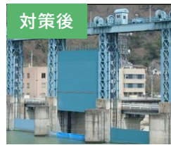
ゲート塗装(耐久性の高い塗料を使用) 劣化状況を評価の上、更新
