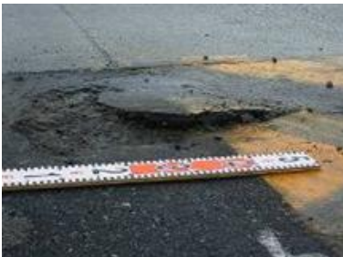
老朽化した舗装により航空機の遅延が発生
