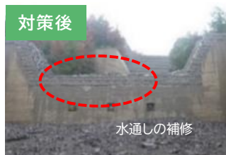
対策後 水通しの補修
