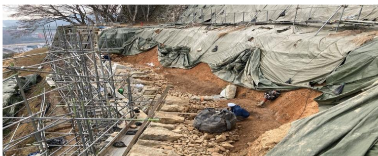
石垣整備：一旦解体し栗石や裏込石を詰め直す作業
