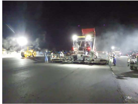
滑走路舗装の舗設
