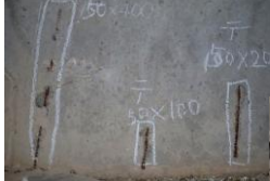
損傷状況(橋脚鉄筋露出)
