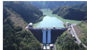
埼玉県 合角ダム
