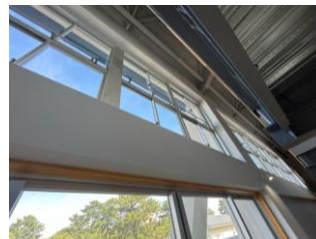
内壁、外部建具の改修状況
