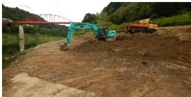
京都府 高山ダム
