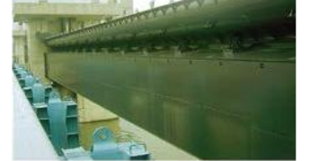
ゲート塗装の塗り替え
