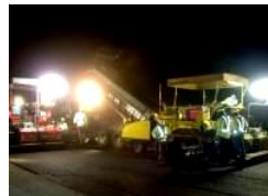
老朽化した滑走路舗装の 改良
