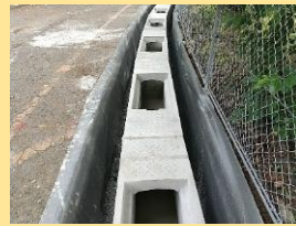
新設した浸透側溝
