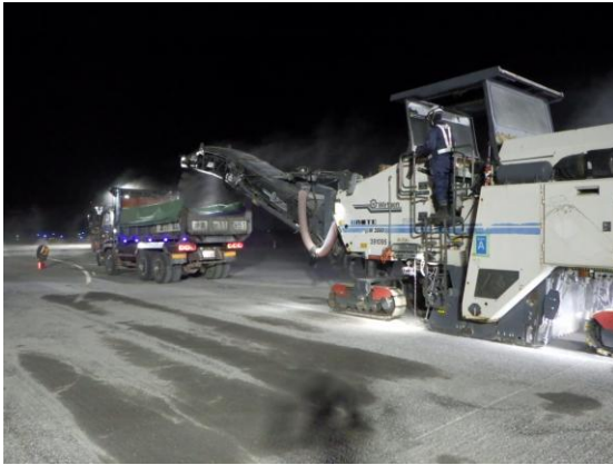
老朽化した滑走路舗装の撤去
