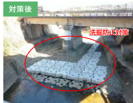
護床ブロックによる洗掘対策
