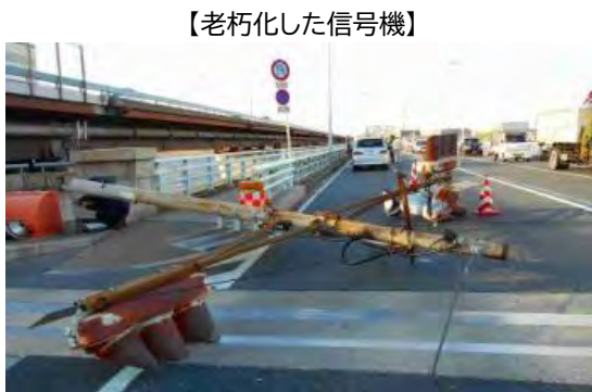
信号柱の倒壊
