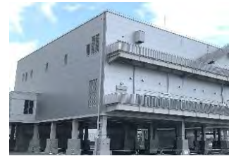
電気設備の地上化
