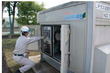
非常用発電機の設置
