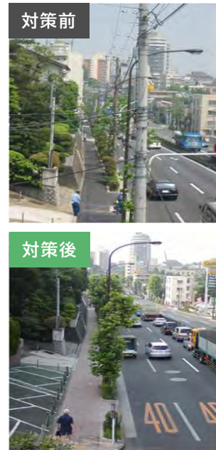
電柱の撤去により、道路の安全性を確保
