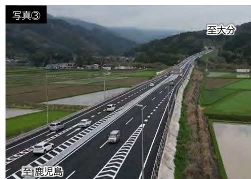
東九州道 清武南IC～日南北郷IC間 開通時の状況(R5.3)
