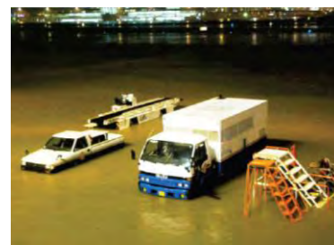
空港における豪雨による冠水被害事例 (平成21年7月 福岡空港)
