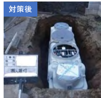
合併処理浄化槽設置
