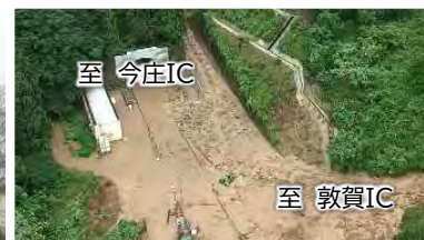
トンネル坑口部における土砂の大規模流入
