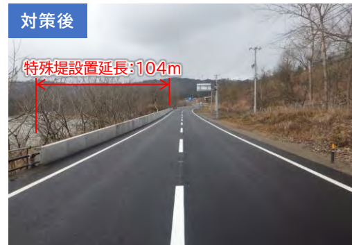
道路沿いに特殊堤を設置
