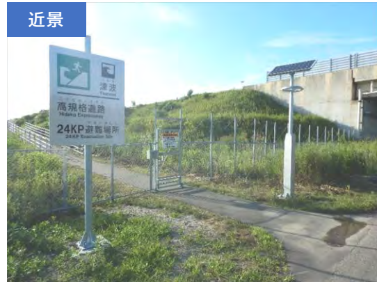
津波等の発生時はスロープを使用して避難が可能
