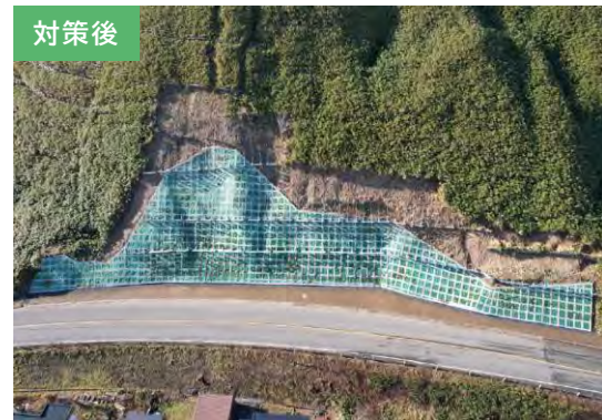
同区間において法面対策を実施
