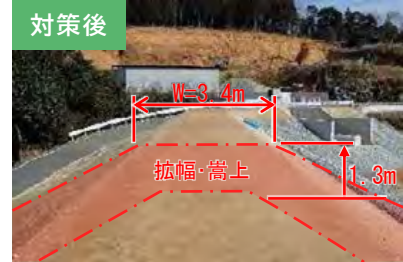
堤体の拡幅・嵩上(W=3.4m,h=7.0m)
