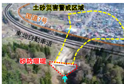
土石流を捕捉する砂防堰堤を整備
