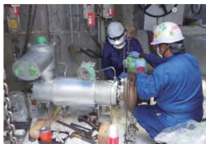
処理施設における補修作業
