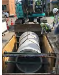
既設下水道管の増径
