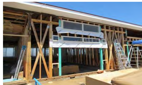
整備中の様子
