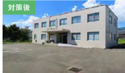
対策後 防水性の確保(屋上に防水塗装を施工)
