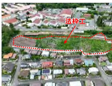
がけ崩れを防ぐ法枠工を整備
