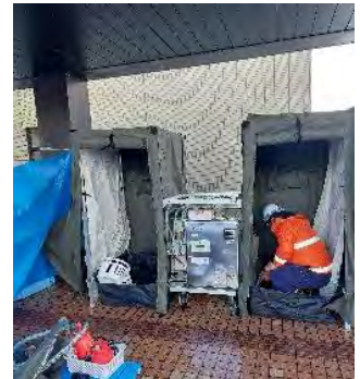
シャワーブース設置状況
