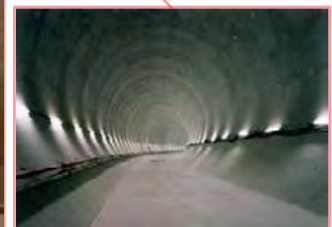
シールドトンネル
