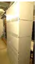
経年劣化した電話交換設備の更新
