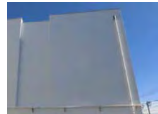
外壁剥離等の落下対策
