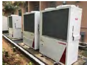
空調機更新による老朽化対策
