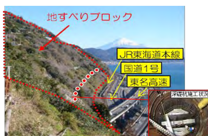
地すべりを防ぐ深礎杭等を整備
