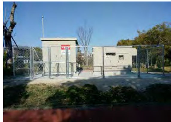
非常用発電設備の整備
