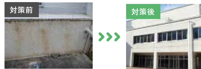
漏水の防止・壁剥落の防止
