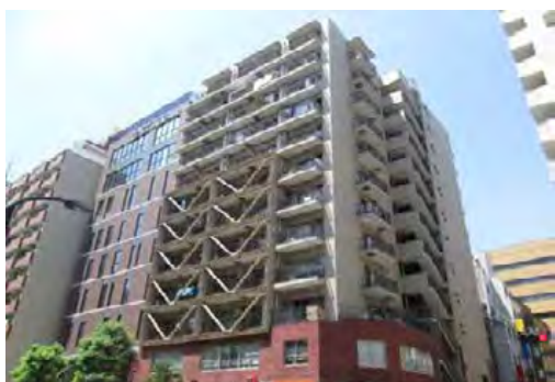
耐震改修を実施した建築物
