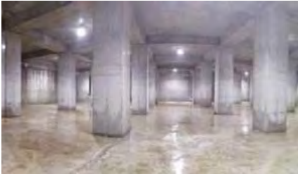
雨水調整池の整備
