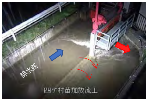
排水路に新設した余水吐へ雨水が流入している様子。 余水は幹線排水路に流入する。
