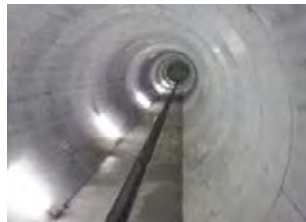
雨水貯留管の整備
