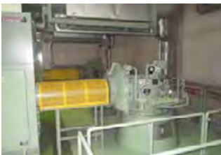
排水ポンプの増設
