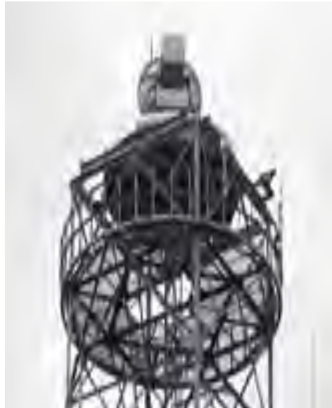
災害時において現場状況を把握するための設備
