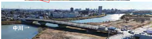
堤防整備・橋梁対策の整備事例(中川 吉川橋付近)
