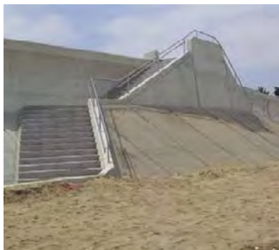
階段・スロープ等の整備
