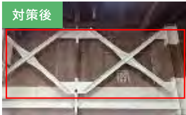
壁面への耐震ブレースの設置
