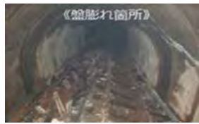
①覆工補修
