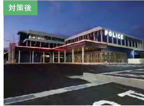
対策後 現地建替により、災害発生時における警察活動の中核拠点としての機能を確保
