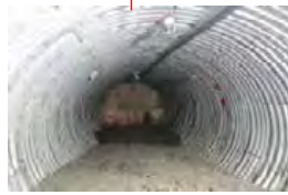
②坑道内整備
