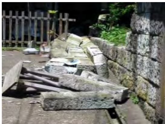
ブロック塀の改修等により、地震によるブロック塀の倒壊を防止
