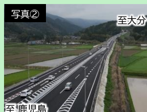
写真② 東九州道 清武南IC～日南北郷IC間 開通時の状況 (R5.3 至大分)
