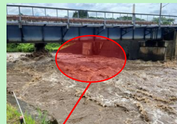
橋脚周囲に根固めブロック・根継工を実施
