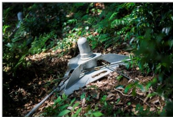
▲ ノンフレーム工法
