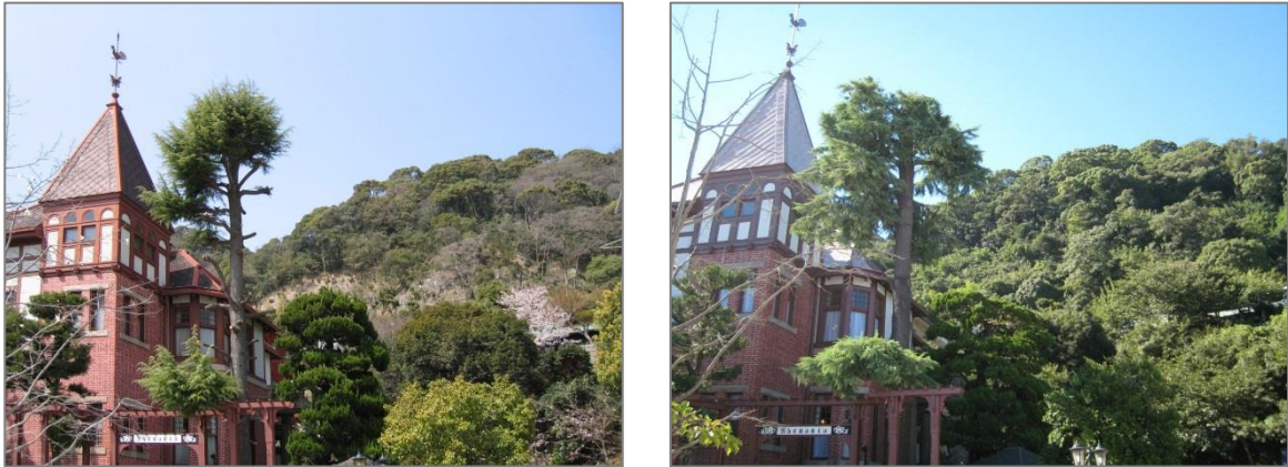
▲神戸北野異人館 風見鶏の館の裏の六甲山中腹 施工直後と施工後 6 年
