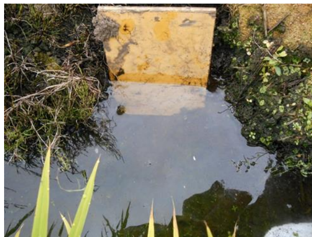
▲止水板による止水状況
