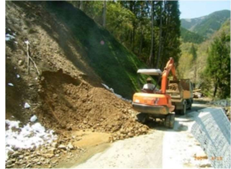
▲土砂崩れ現場での作業
