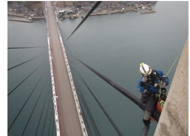
▲足場を架けない橋梁調査
