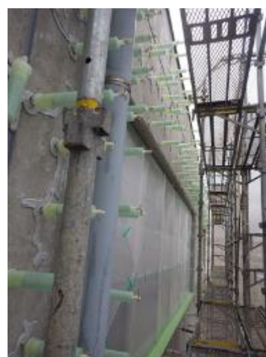
▲島根県環境保健公社 総合健診センター外壁補修工事
