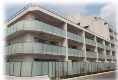
▲耐震補強工事施工後
