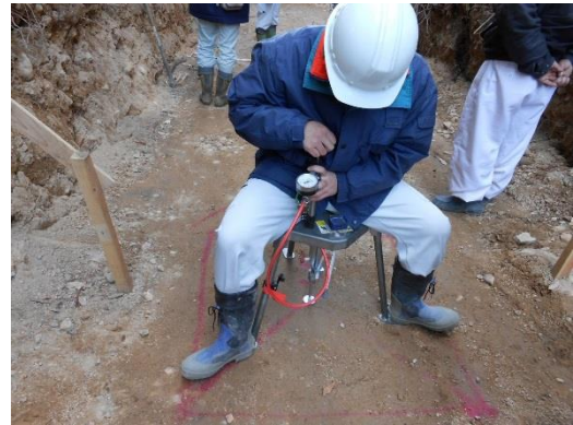
▲地盤支持力確認試験の状況
