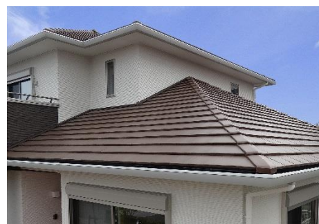
▲洋風防災瓦の施工例
