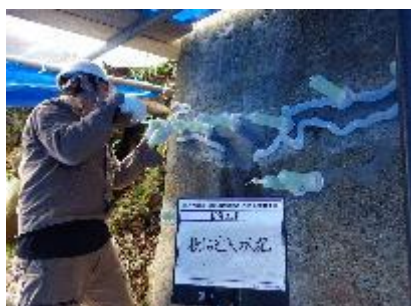
▲樹脂注入の様子
