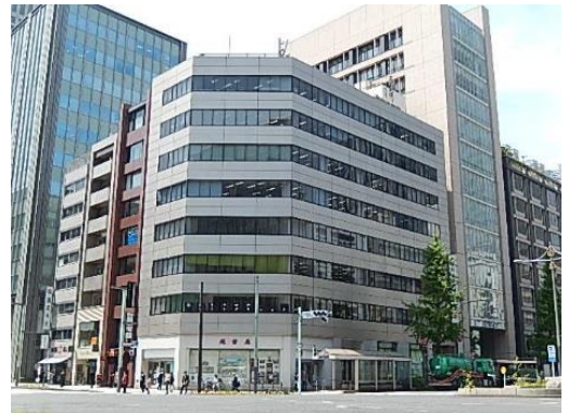
▲特定緊急輸送道路建築物耐震補強工事
