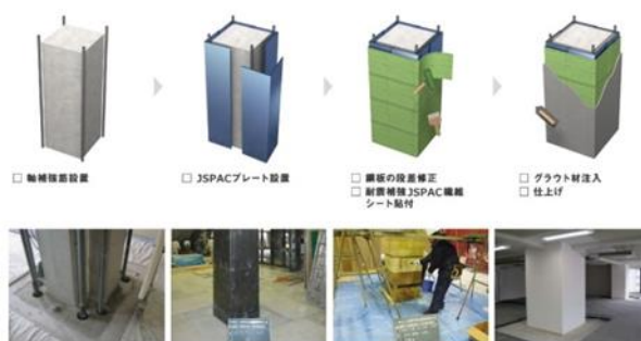
▲JSPAC 耐震工法の施工の様子
