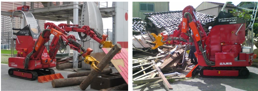
▲新潟県中越地震後の柏崎市での作業の様子
