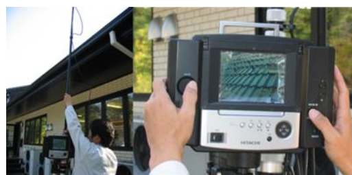
▲ポールカメラ診断の様子
