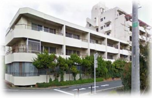
▲耐震補強工事施工前
