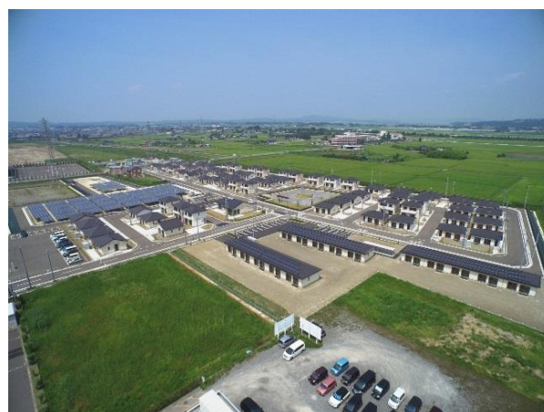
▲東松島市スマート防災エコタウン
