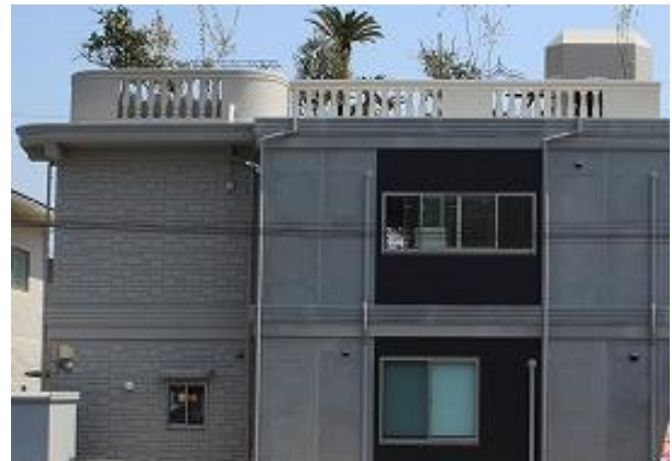
▲屋上に設置している避難シェルターペントハウス
