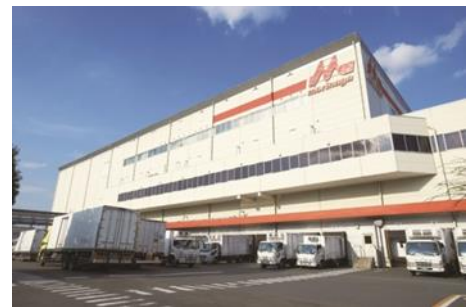
▲森永乳業 東京多摩工場
