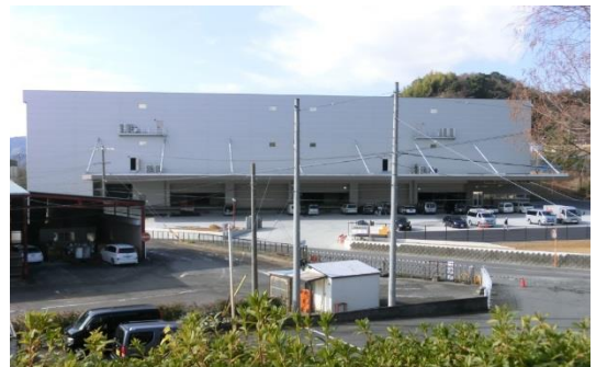
▲高台移転した静岡物流センター
