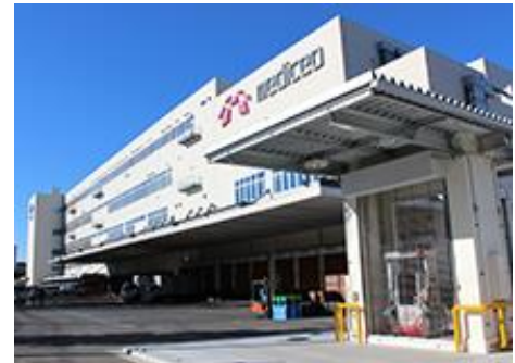
▲自家給油設備を設置している 物流センター（神奈川 ALC）
