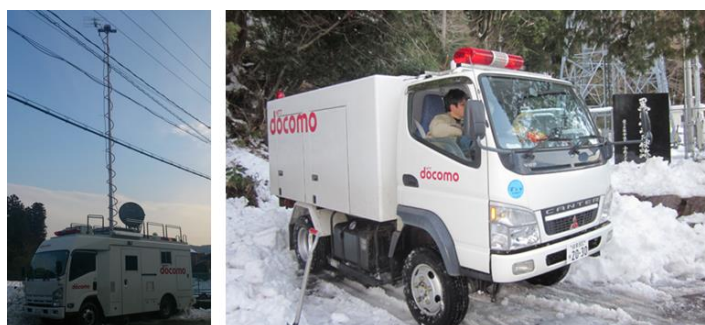
▲移動基地局の設置
