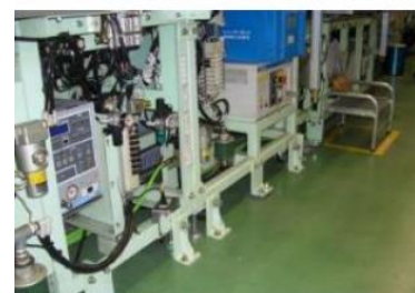
▲倒壊対策した機器類
