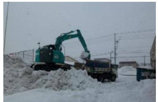
▲バックホウとダンプによる除排雪
