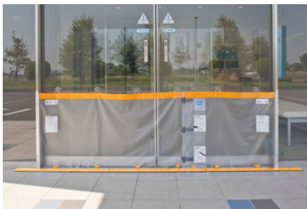
▲止水シートの設置
