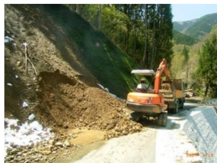
▲土砂崩れ現場での作業
