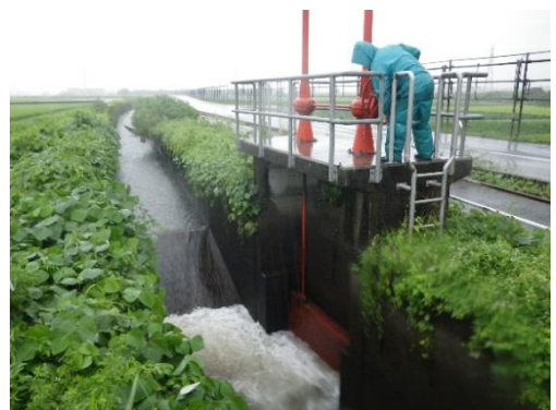
▲東二号幹線用水路の柴落余水吐
