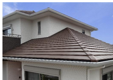
▲洋風防災瓦の施工例
