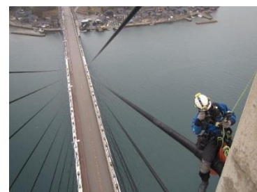
▲足場を架けない橋梁調査
