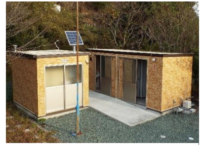
▲循環サイクルトイレ外観
