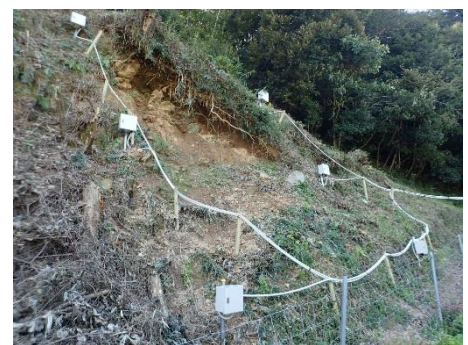
▲検証拠点の 1 つである島根県津和野町での実証実験の様子
