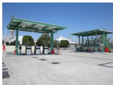
▲杉戸燃料備蓄基地の外観
