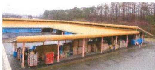
▲大型の物資が積まれた屋外施設
