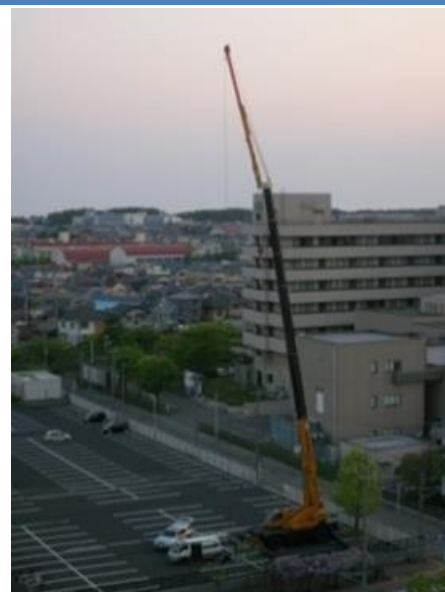
▲クレーン車での空中線設置
