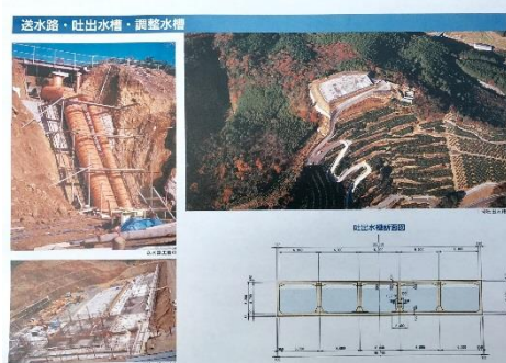
▲湖北揚水機場から送水する 管路・吐水槽施設
