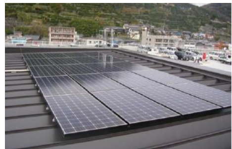
▲減災型ソーラーパネルの設置
