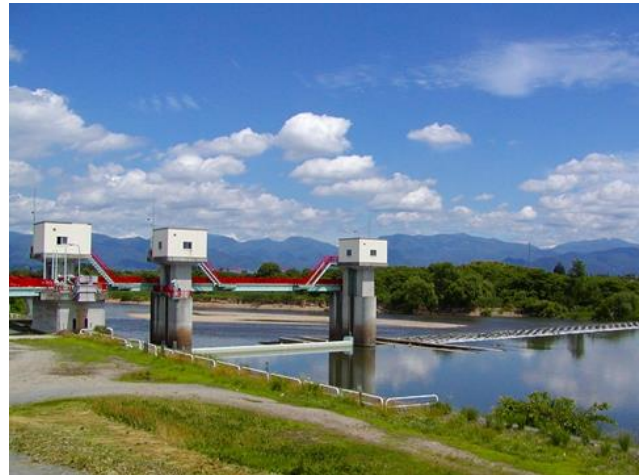
▲最上川から農業用水を取水する三郷堰頭首工
