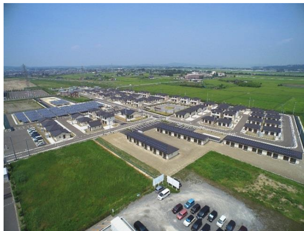
▲東松島市スマート防災エコタウン
