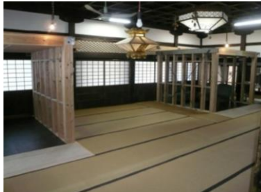
▲耐震シェルターの施工例
