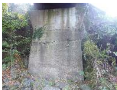
▲橋梁 ひび割れ補修施工前
