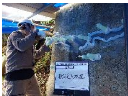
▲樹脂注入の様子
