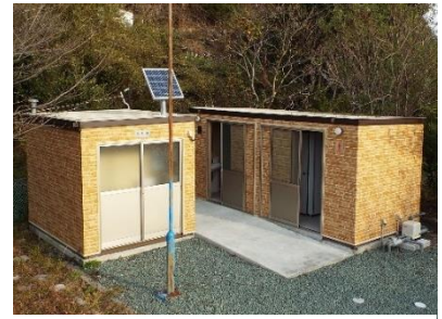
▲循環サイクルトイレ外観
