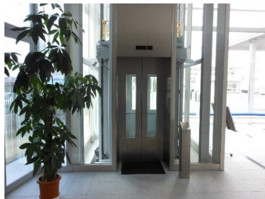
▲導入したエレベータ
