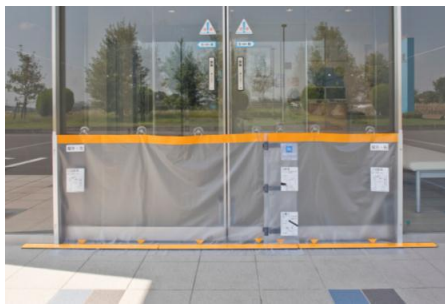
▲止水シートの設置
