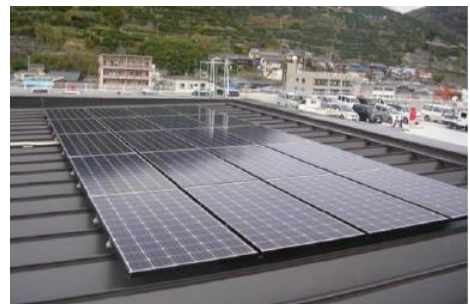
▲減災型ソーラーパネルの設置
