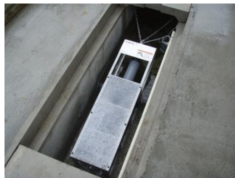
▲水流を利用した小水力発電 「ピコ発電」
