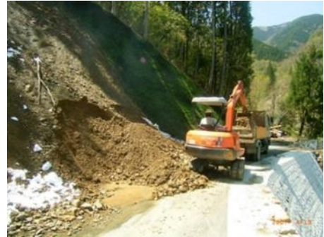
▲土砂崩れ現場での作業
