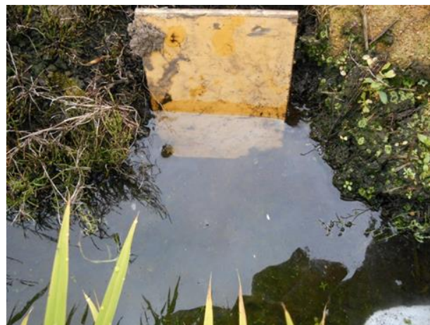
▲止水板による止水状況
