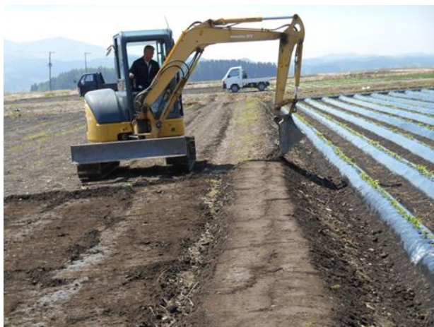
▲バックホーによる復田の畦畔嵩上げ
