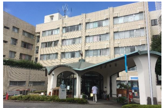
▲東京都二次緊急医療機関の耐震補強工事
