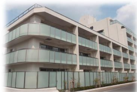
▲耐震補強工事施工後
