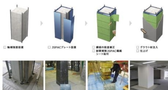
▲JSPAC 耐震工法の施工の様子
