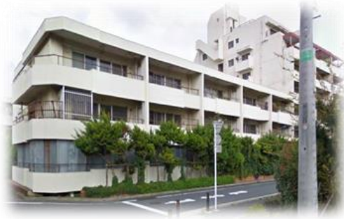
▲耐震補強工事施工前
