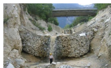
▲スイスでの土石流の捕捉実験
