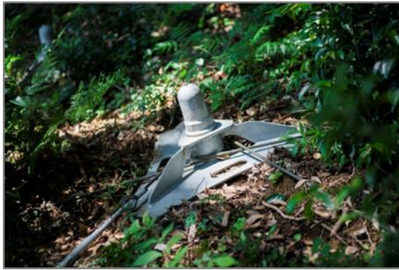
▲ ノンフレーム工法
