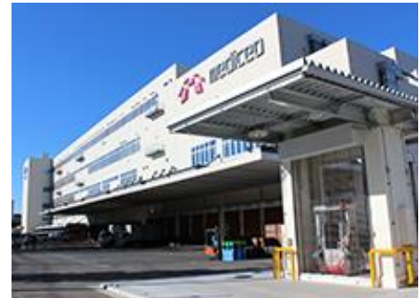
▲自家給油設備を設置している 物流センター（神奈川 ALC）
